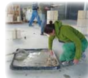
Formation maçon du bâti ancien
