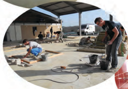
Espace second oeuvre Espace gros oeuvre Aire CACES
