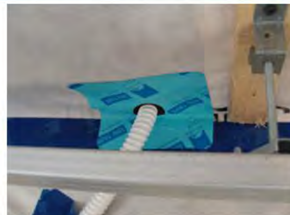
Élément spécifique permettant la traversée de la membrane par une gaine ou un câble électrique
